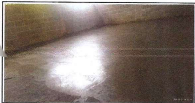
Foto 5: Colocación de pisos, reemplazo de la anterior.
