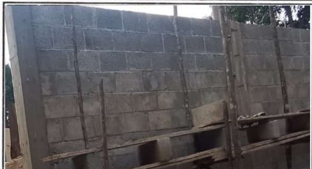
Foto 2: Proceso de colocación de paredes de block, reemplazo de las paredes de maderas.
