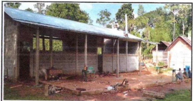
Foto 6: Colocación de láminas troqueladas.
