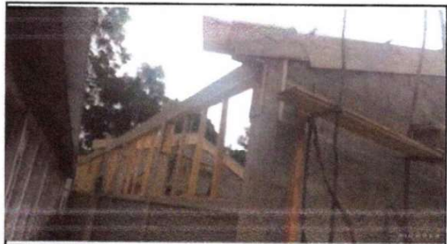
Foto 4: Coronación y fundición de horcones, culminación de las paredes
