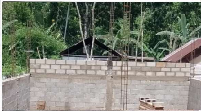
Foto 3: Colocación de horcones de concreto.
