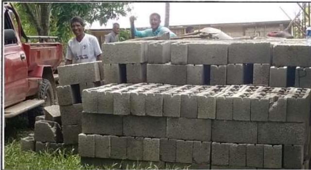
Foto 1: Inicio de almacenamiento de block colocación de los horcones de metal y concreto. Reemplazo de los horcones de madera.
